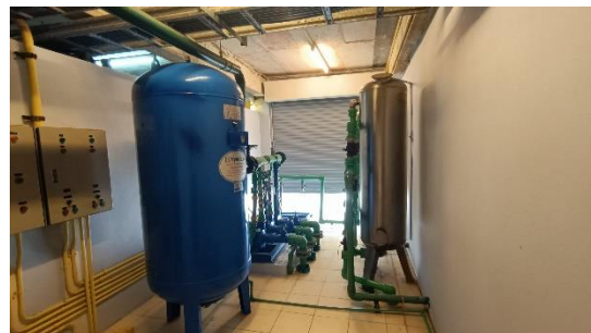
ภาพที่ 20 ระบบถังกรองน้ำใช้
