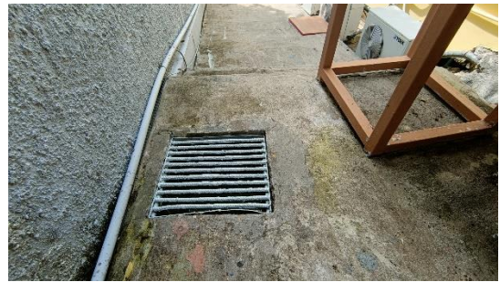
ภาพที่ 22 ตะแกรงดักขยะ
